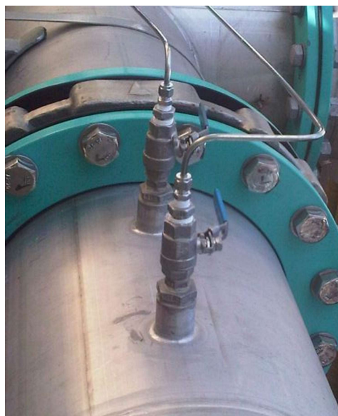
Figure 9 - Ensemble vanne à boisseau sphérique
